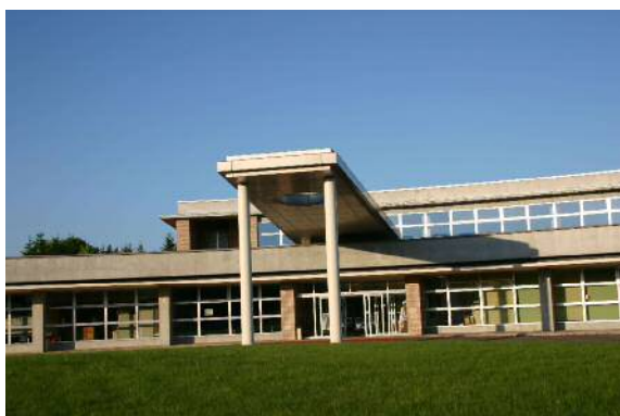
《中標津町総合福祉センター 外観》
